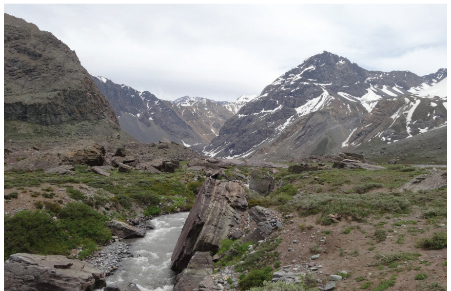
Vodozahvat na visoravni La Engorda
