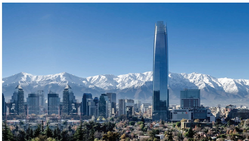
Noviji, sjeverozapadni dio grada moderno je uređen
