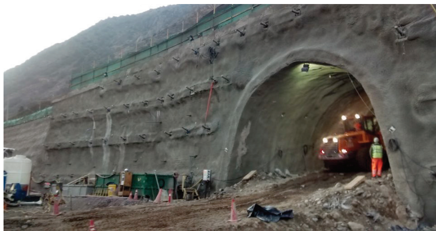
Alto Maipo - pogled na gradilište
