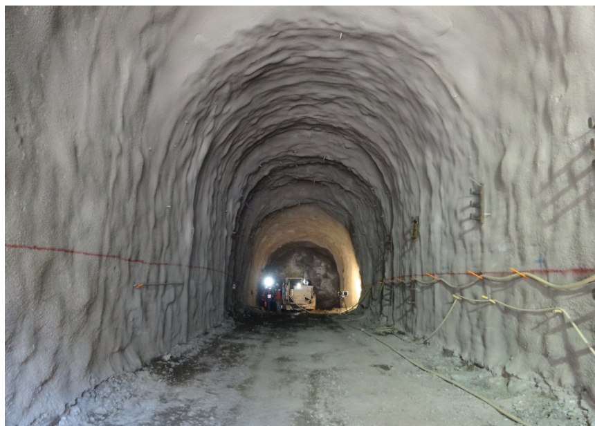
Iskop tunela V1 s primarnom podgradom osiguranom sidrima i prskanim betonom
