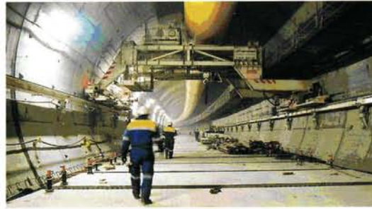
Slika 8. Pogled na unutrašnjost tunela za osobna vozila (tunnel est) tokom izvedbe
