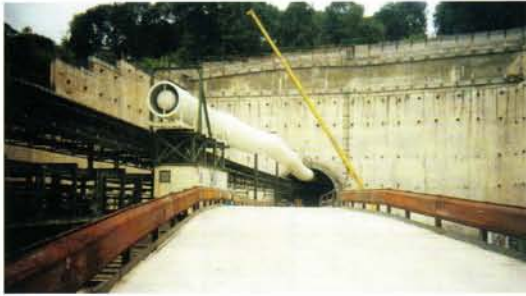
Slika 7. Ulazni portal tunela za osobna vozila (tunnel est) u Rueil Malmaisonu
