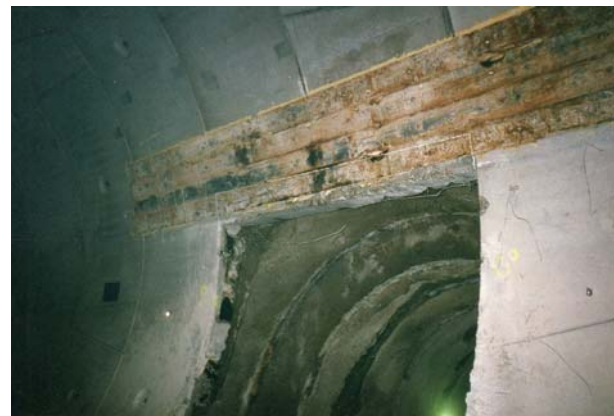
Slika 15. Poprečni prolaz između dviju tunelskih cijevi s privremenom potporom krune segmentne obloge uz uporabu čeličnih ploča zalijepljenih na betonsku segmentnu oblogu
