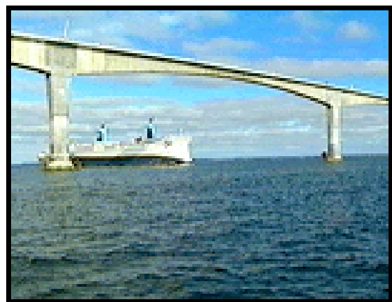
Sl.13 Most Northumberland Crossing : jedan od 44 središnja raspona od 250 m glavnog mosta.
