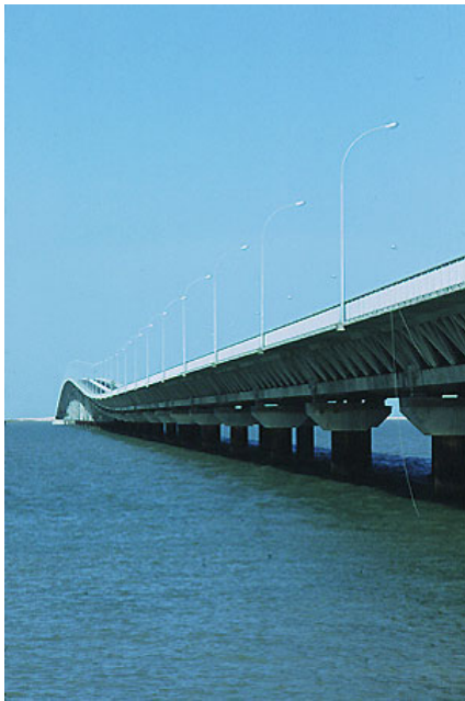
Sl.11 Most Bubiyan preko Subiya kanala, Kuwait.
