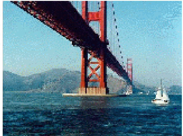
Sl.5 Golden Gate Bridge preko zaljeva San Francisco Bay između San Francisca i Sausalita u Kaliforniji, SAD.
