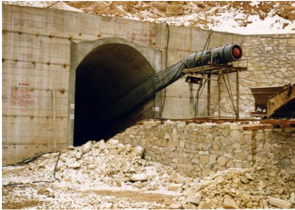
Slika 17. Portal tunela 5 s ventilacijskim sustavom
