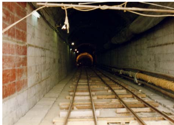
Slika 16. Portalni dio kosog tunela 7 s tračnicama
