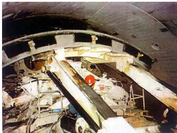
Slika 6. Izvedba tunela TBM tehnologijom (primjer iz Pariza)
