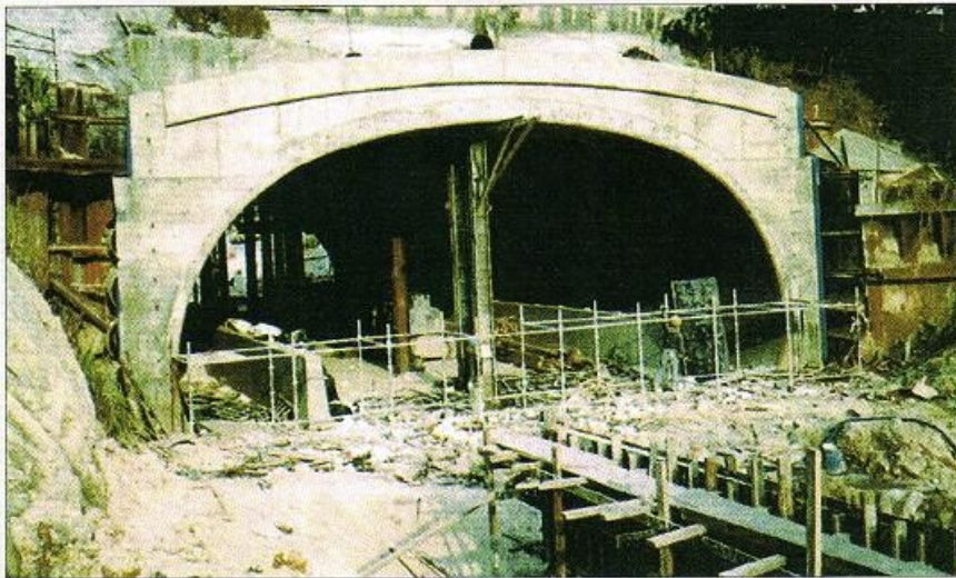
Slika 11. Dvršena trajna građevina tunela uz portal
