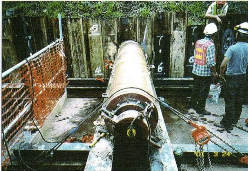
Slika 9. Zabijanje cijevi uz kraj za zabijanje
