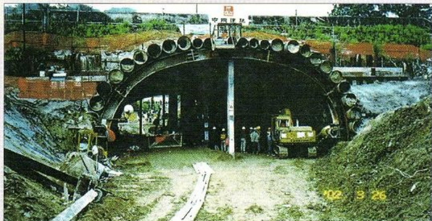
Slika 10. Privremeni cijevni svod pri završetku iskanjanja
