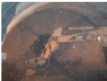
Slika 16. Fazni izkop v kaloti v hribinski kategoriji SCC2 v predoru.
