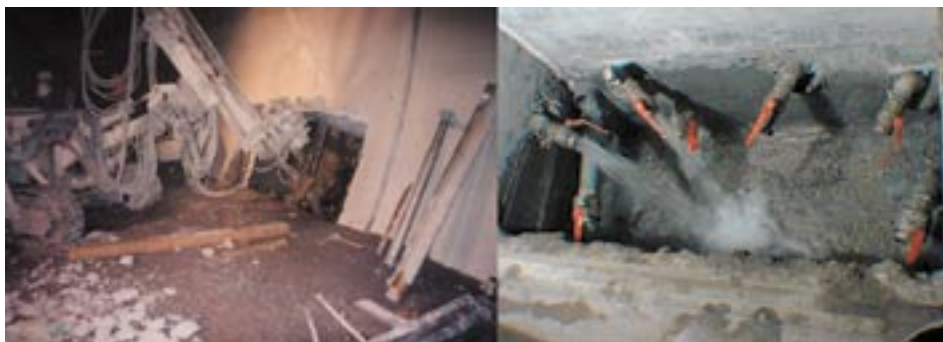
Foto 1: Vrtanje drenažnih vrtin v niši št. 6 na vzhodni strani predora (levo), detajl niše po betoniranju – pogled od zgoraj (desno).
