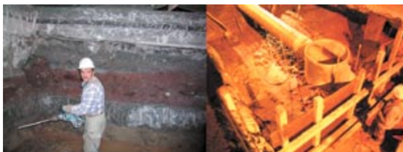
Foto 3: Izkop segmenta št. 4 na zahodni strani: lepo vidna stratifikacija tehničnih plasti; spodaj še viden talni obok (levo). Postavitev glavnega kanala z revizijskim jaškom v segmentu št. 16 na vzhodni strani (desno).
