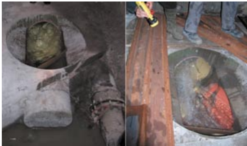
Foto 2: Obvodni kanal: vtok (levo) in zasun pred vtokom v glavni kanal (desno)
