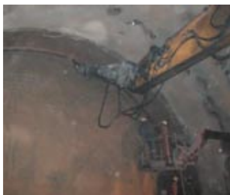
Slika 6. Vgradnja talnega oboka iz brizganega cementnega betona MB25 debeline 35cm.
