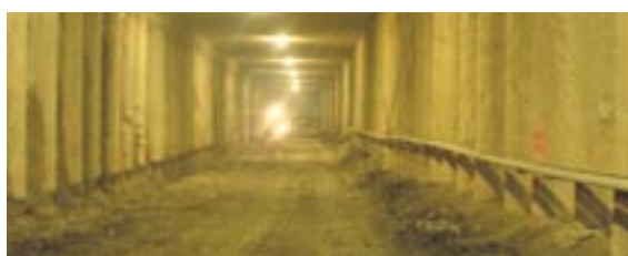
Slika 4-2: Faze gradnje pokritega vkopa
