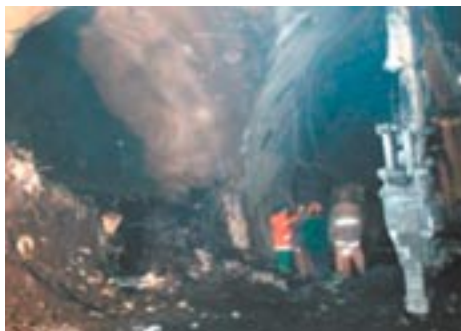
Slika 10. Pričetek izkopa povoznega prečnika
