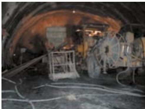
Slika 11. Priprava na vgradnjo jeklene- ga cevnega ščita
