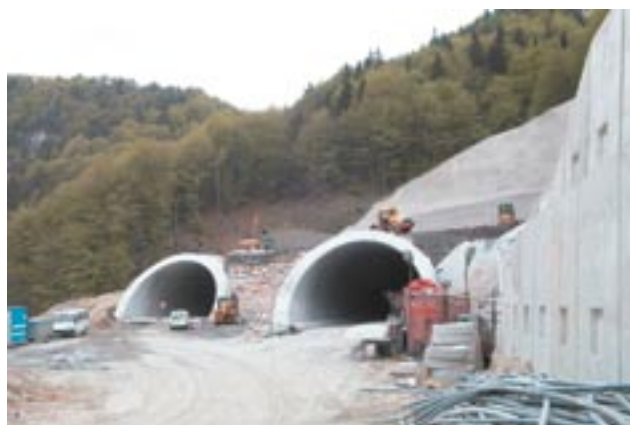
Slika 3 : Vzhodni predkop - končni portal
