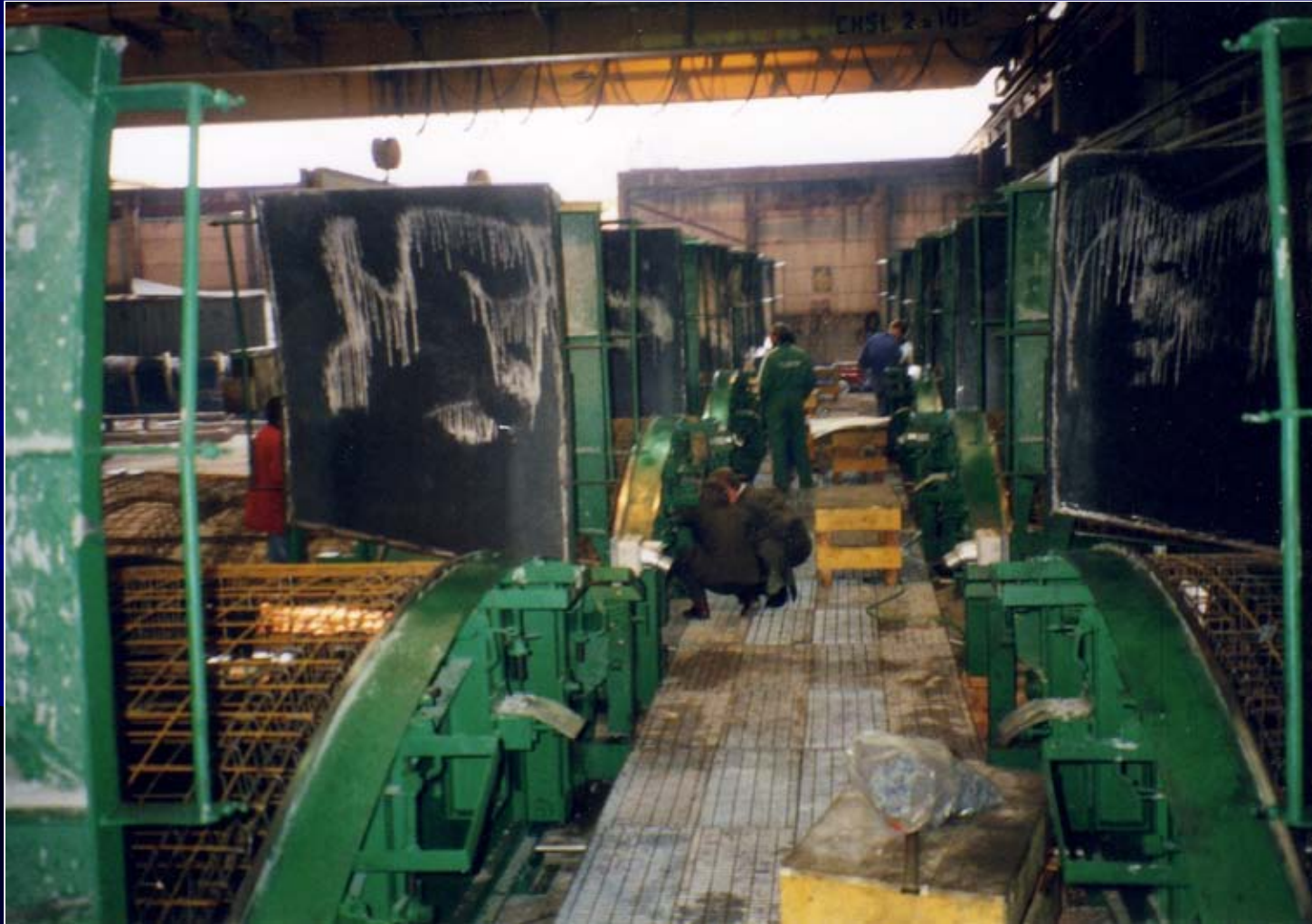
Linije R.E.R. "E" , sekcija 35B u centru Pariza Tvornica elemenata segmentne AB obloge tunela : stacionarni kalupi
