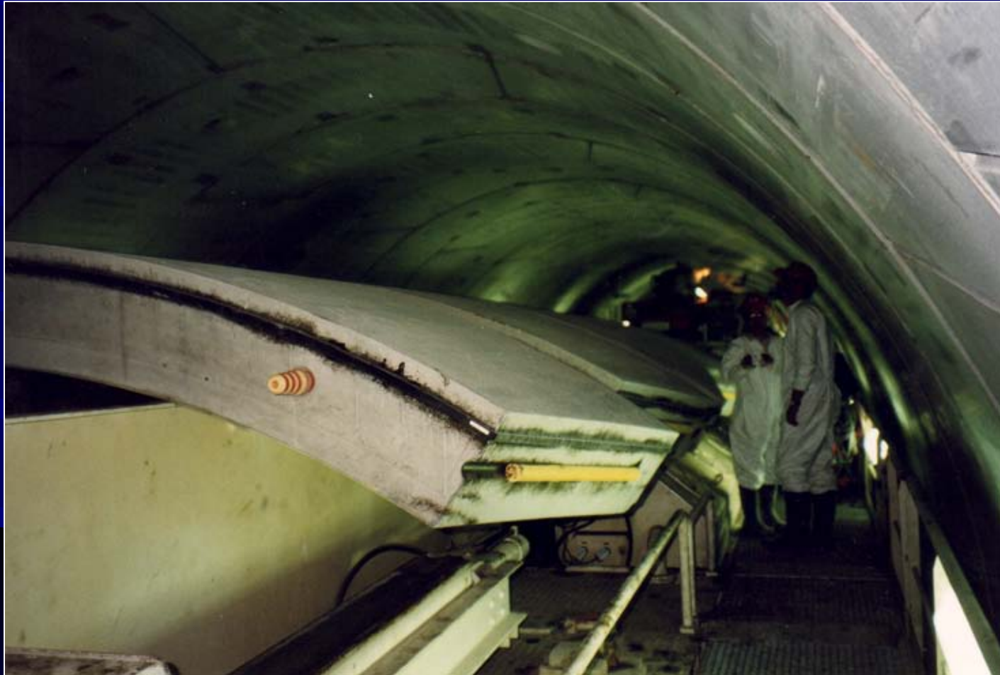
Linije R.E.R. "E" , sekcija 35B u centru Pariza Segmentna obloga tunela na "stolu" neposredno prije montaže. Str. 14/ 20
